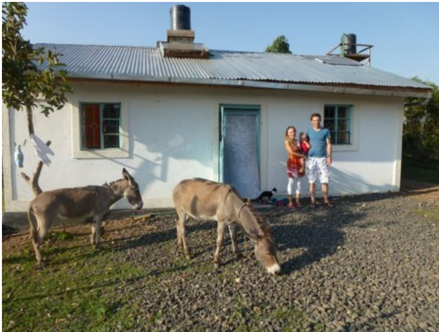
Abbildung 4: Montierter Warmwasser Kollektor links und Photovoltaiksystem rechts
