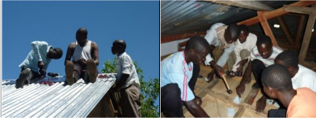
Abbildung 3: Montage des Solarpanels (l) und der Kabel (r)
